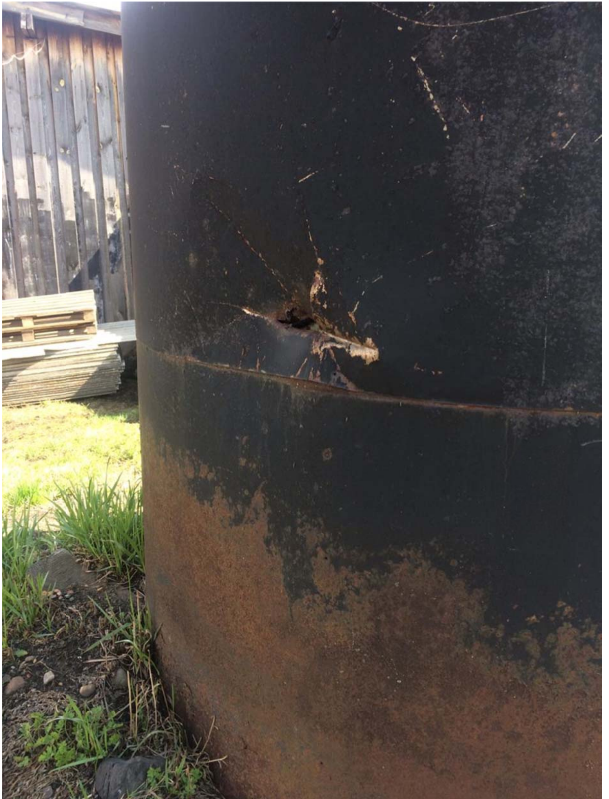
Фото 2. Следы механических повреждений металлических конструкции.
